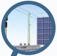
Kabel für Oberleitung
